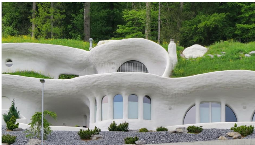
Рис.1 Швейцария, дом-землянка. Архитектор Петер Ветш. Фото: pixu.org
