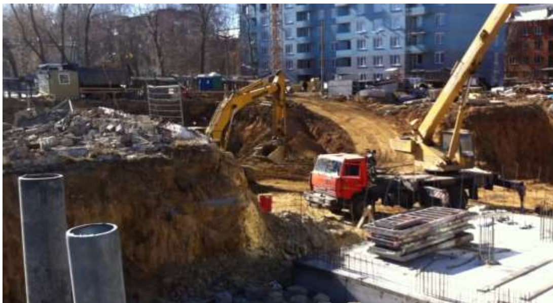
3-rasm. Lyosli gruntlar ustiga sifatli va seysmik xavfga chidamli qatlam o'rnatish.
