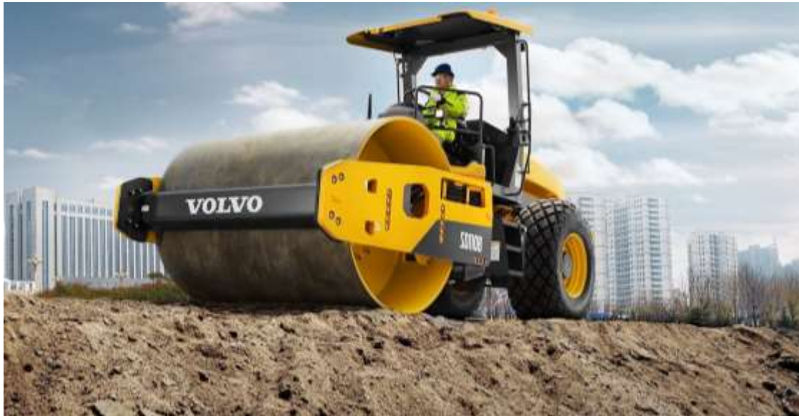
1-rasm. Lyosli gruntlarni zichlash.
