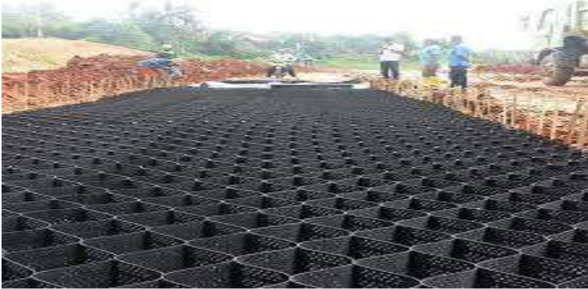
2-rasm. Lyosli gruntlar ustiga quyilgan geosintetik matyeriallar.
