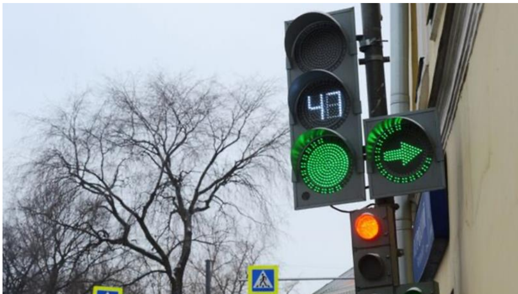
Рис. 1. Умный светофор с цифровым счетчиком, показывающим длительность зеленого сигнала.
