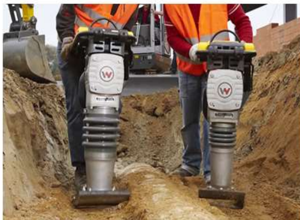
3- расм. Грунтни zichlash usullari.
